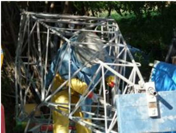
Sablage de la cellule
